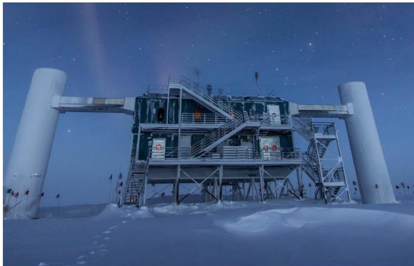
بخش بیرونی رصدخانه نوترینوی آیس کیوب در قطب جنوب
