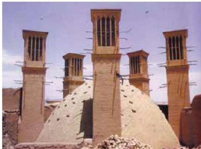
تصویر شماره ۲-۵۰- آب انبار و بادگیرهایش
